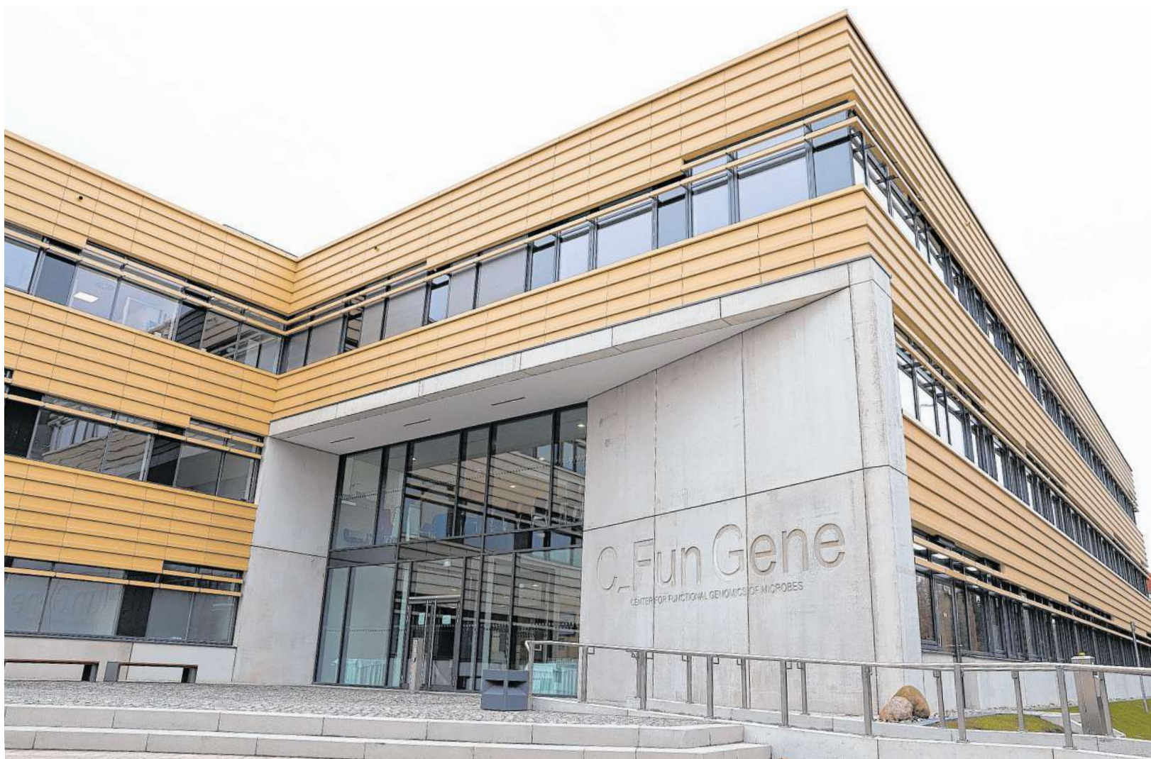
Das neue Gebäude des Instituts für Genetik und Funktionelle Genomforschung, C_FunGene, ist bereits in Betrieb.
